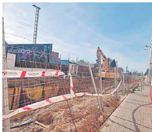
Una imagen de las obras del tanque de tormentas.
