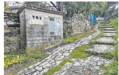
Estación de bombeo de Santa Marta. | S.A.
