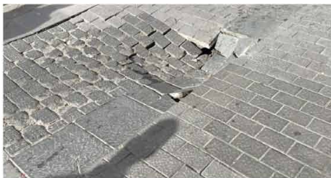
La vía, hundida en la calle Convento. / Á.C.G.
